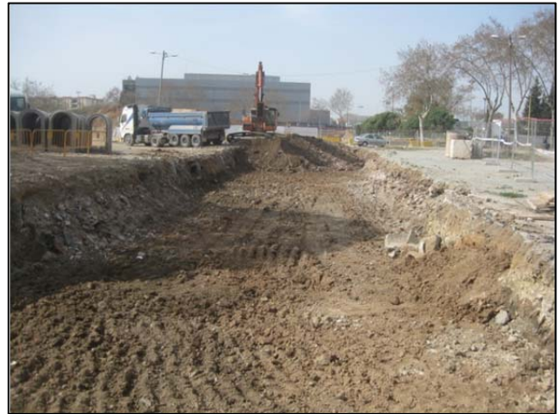
FOTO 6. Preexcavació inicial del tram 4.
