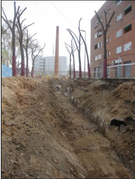
FOTO 17. Treballs de rebaix del Tram 7.
