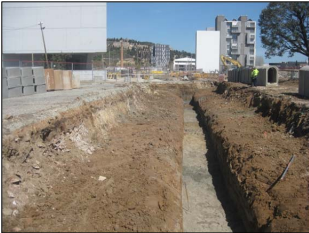
FOTO 5. Rebaix final del tram 4.
