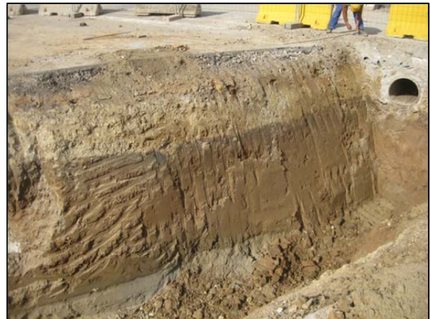
FOTO 20. Vista de detall de l'estratigrafia del Tram 1.
