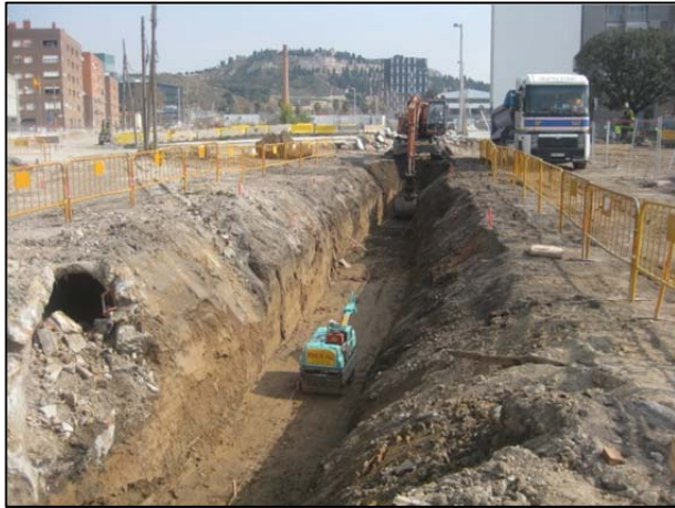
FOTO 9. Tasques de rebaix corresponents a la rasa del col·lector en direcció a Cal Cisó (Tram 2)
