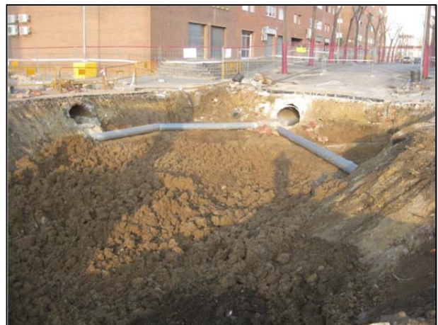
FOTO 12. Rebaix del pantaló 3 (Tram 3).
