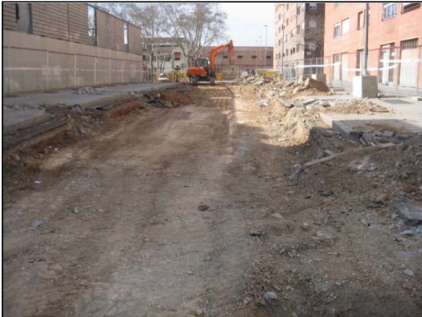
FOTO 13. Retirada de l'asfalt del carrer Pontils.
