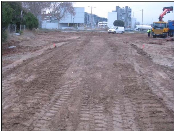
FOTO 1. Vista del Tram 1, abans d'iniciar els treballs de rebaix.
