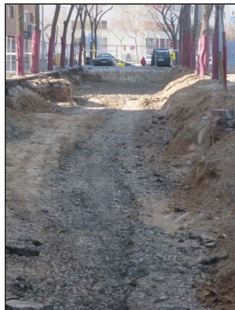
FOTO 16. Retirada de l'asfalt del carrer Sovelles.
